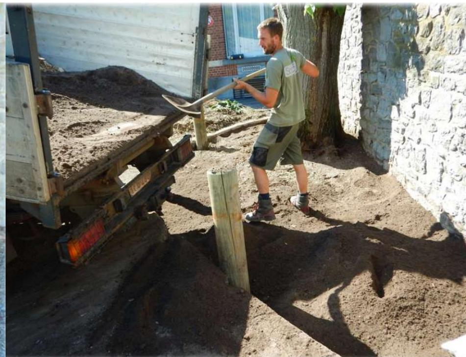
Travaux : Enlèvement du tarmac et du remblai. Décompaction du sous-sol. Apport de terre de qualité. Paillage.
