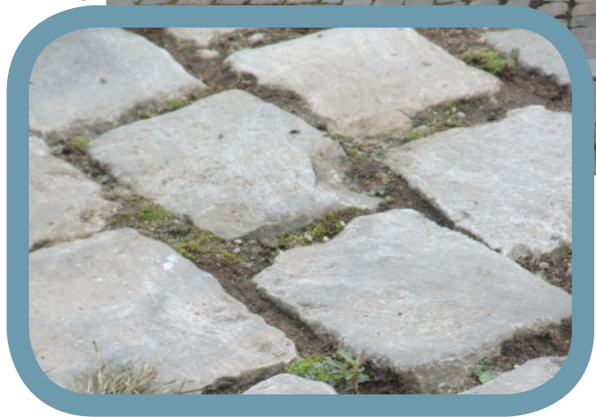
Kopfsteinpflaster, die mit der Kehrmaschine gereinigt wurden
