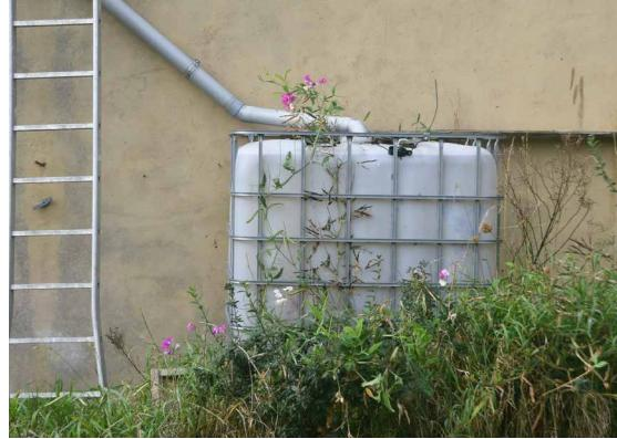
**Différents dispositifs permettent d'infiltrer ou de récupérer les eaux de ruissellement, avec par exemple les noues végétalisées (à gauche) – LILLE 2013 © Adalia 2.0 ; ou les systèmes de gouttières (à droite) – Ecole Wauthier-Braine 2017 © P. Colomb**
