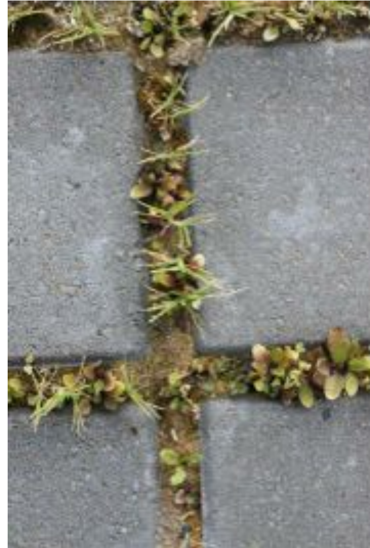
Sable de mer propre, joint de 11mm
