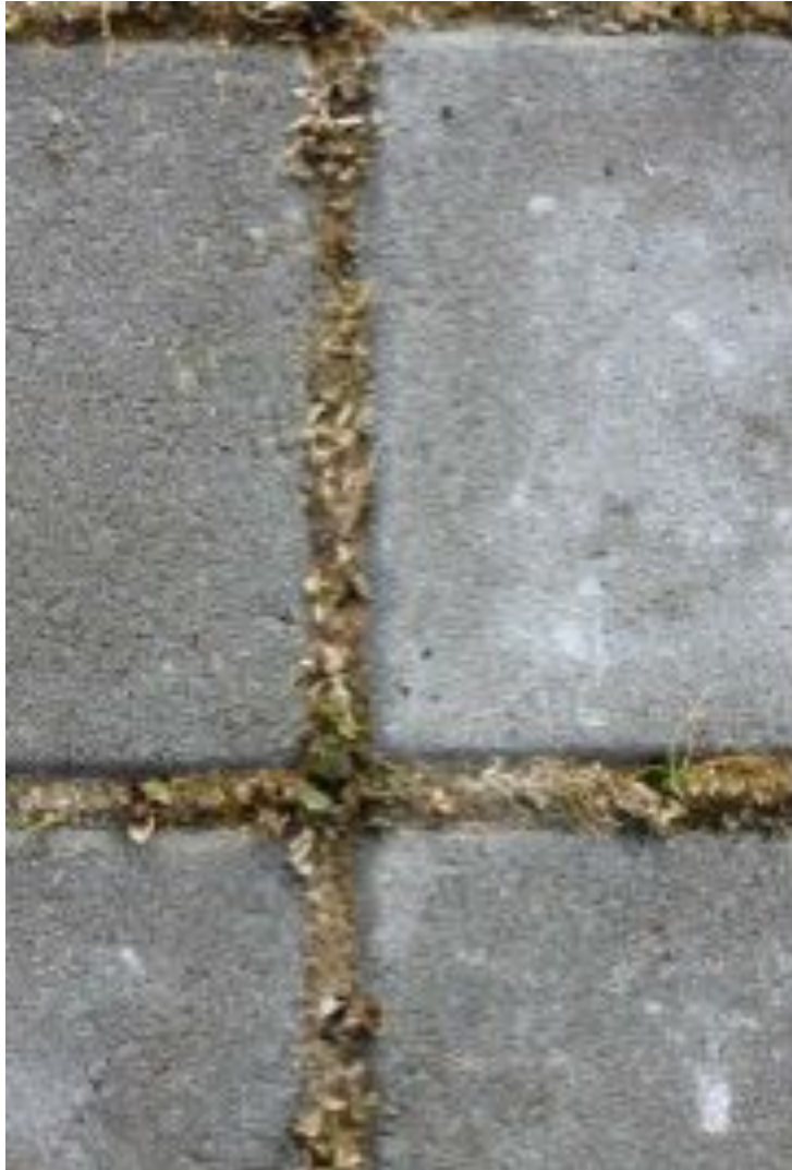
Sable de mer propre, joint de 3mm
