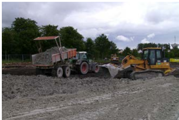
Chantier de construction de sol, © C. Schwartz UL-Inra
