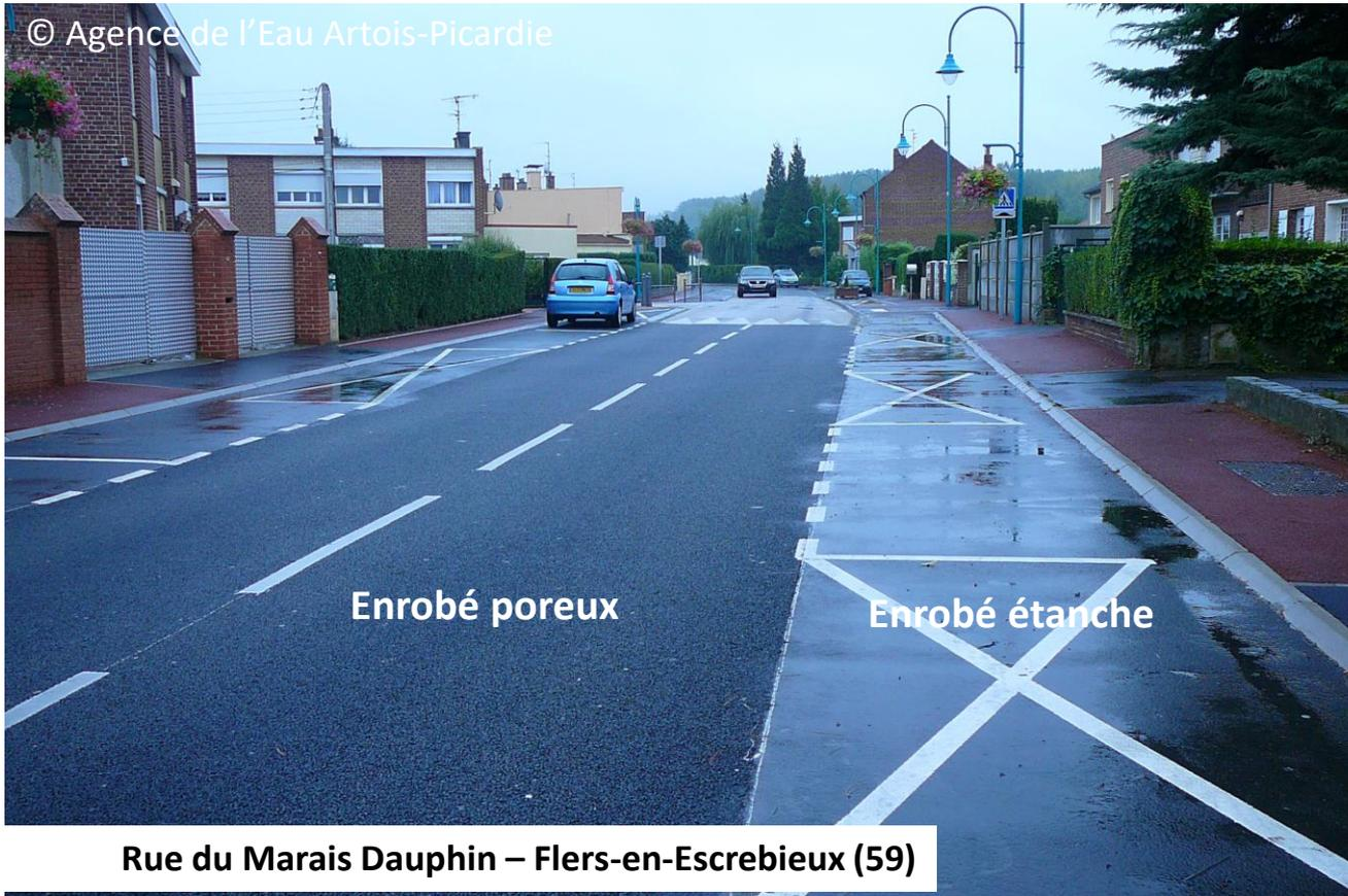
**Chaussée à structure réservoir d'infiltration avec revêtement poreux et classique**
