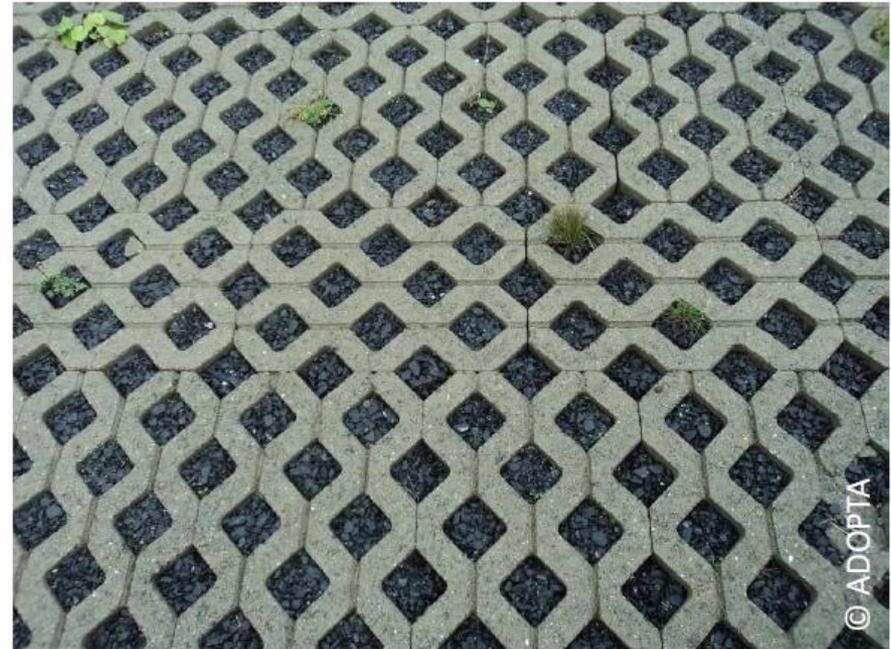
**Zone de stationnement en dalle béton alvéolé**
