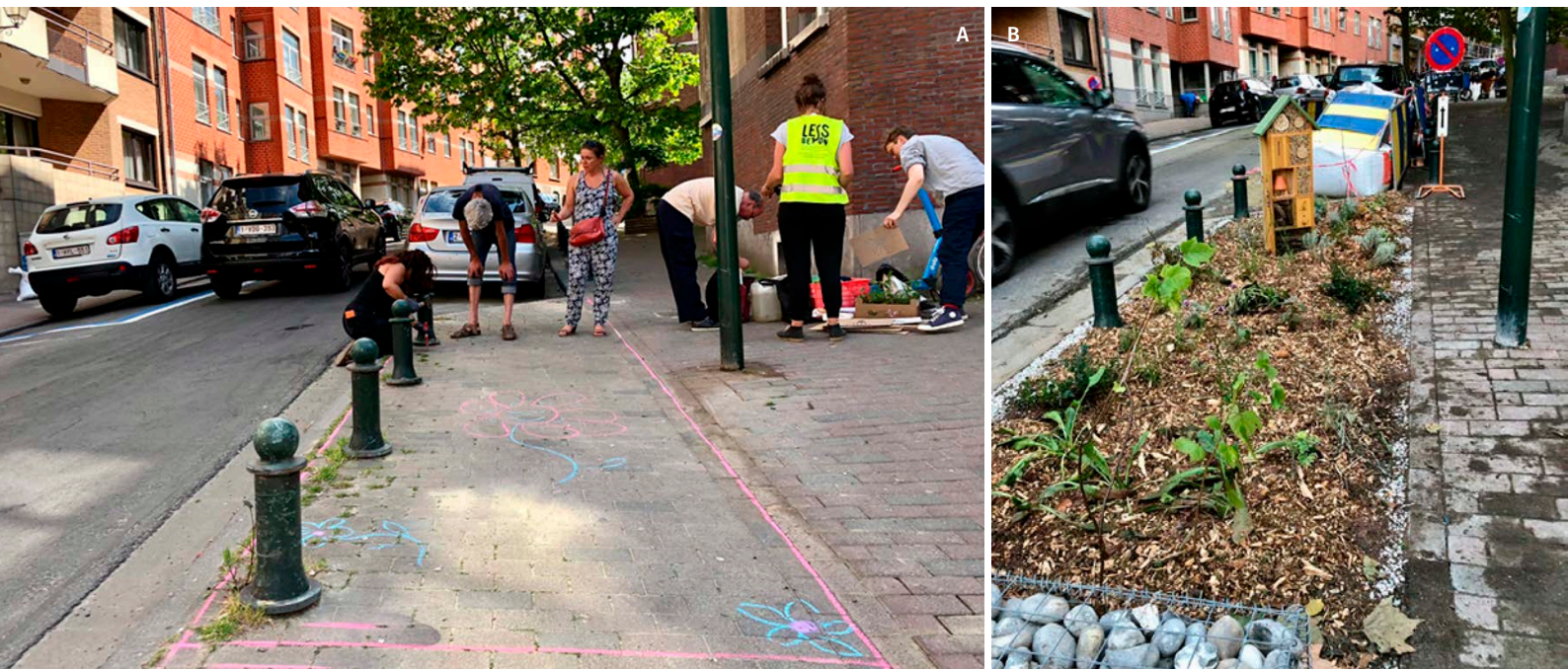
Projet de déminéralisation avant (A) et après (B).
