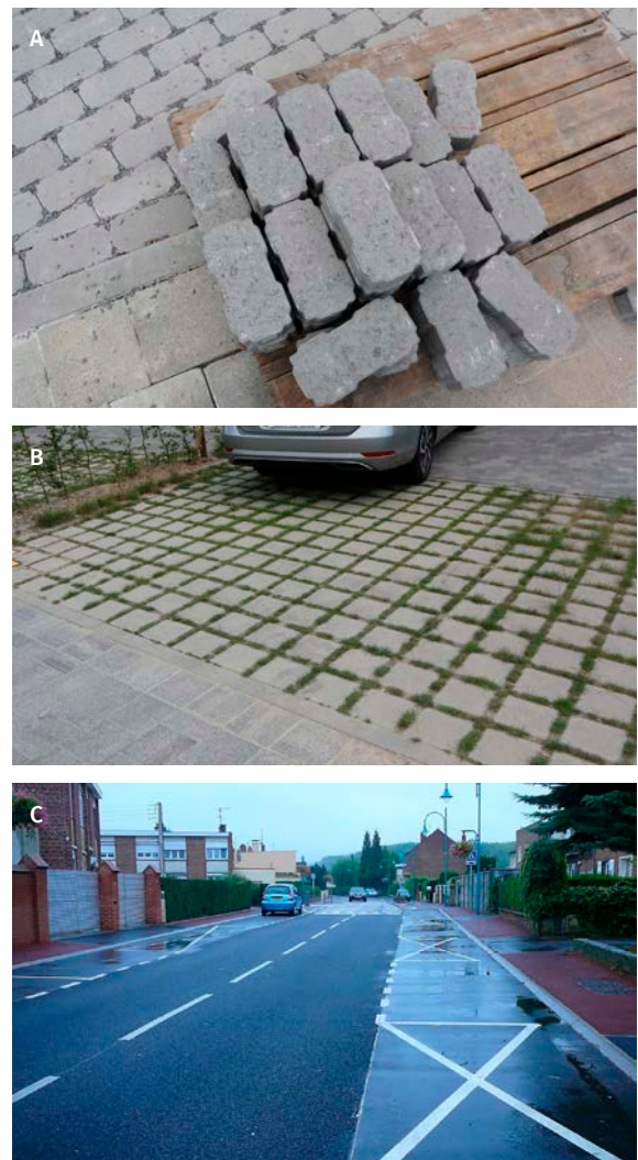
(A et B) Parkings à joints élargis. (C) Rue à revêtement perméable et parkings imperméables.
